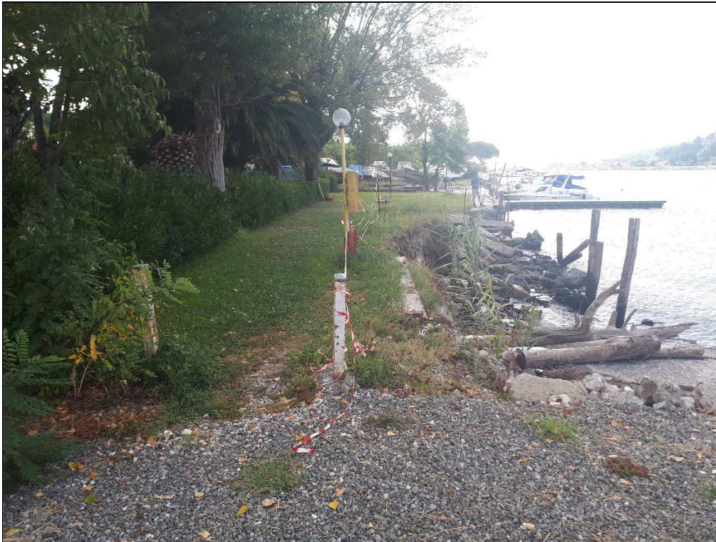
Fotografia n. 3: Ripresa controcampo da monte della concessione della sponda demaniale interessata dalle opere di manutenzione, ripristino e ristrutturazione. Dalla fotografia si intuisce la linea spondale costituita da quello che rimane della precedente palificata.
