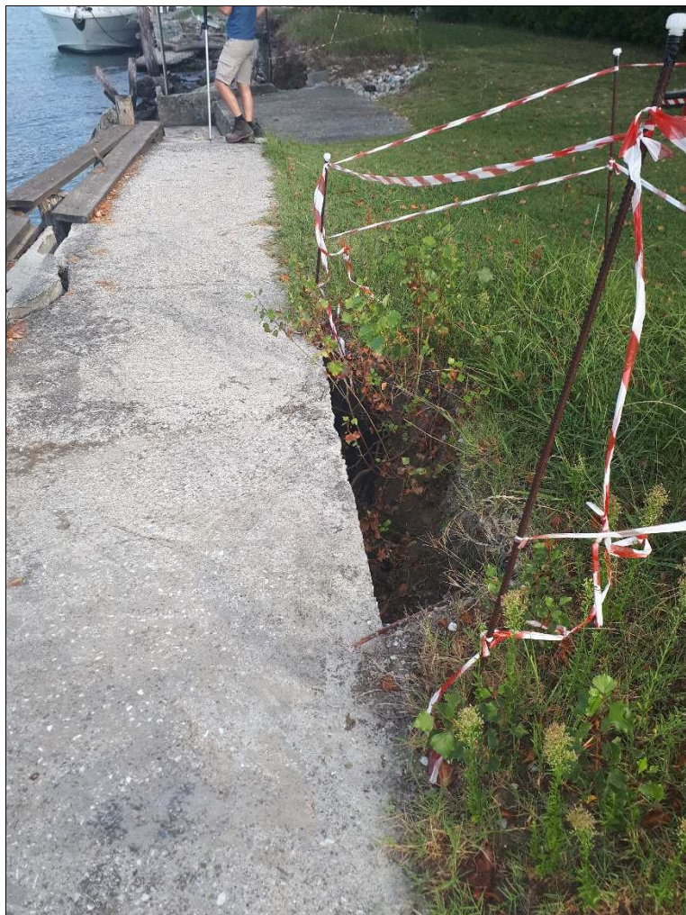
Fotografia n. 7: Vista di dettaglio da valle della sponda e della banchina di ormeggio interessate dalle opere di manutenzione straordinaria e ripristino. Nella ripresa fotografica si vedono chiaramente altri svuotamenti minori prodotti dall'erosione del fiume Magra.
